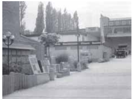
Schade + Sohn - ein Foto aus dem Firmenarchiv.
